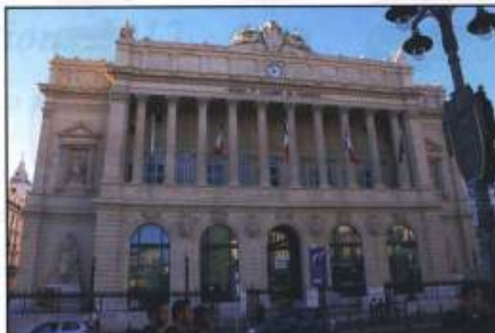
Façade de la Chambre de commerce de Marseille
